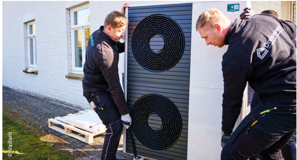
Aufstellung Außeneinheit
