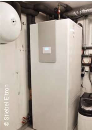
Kompakte Hydraulikeinheit mit eingebautem Pufferspeicher, Warmwasserspeicher und Regelung
